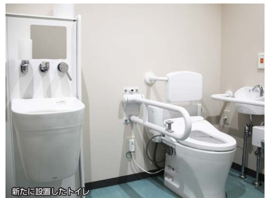
新たに設置したトイレ
